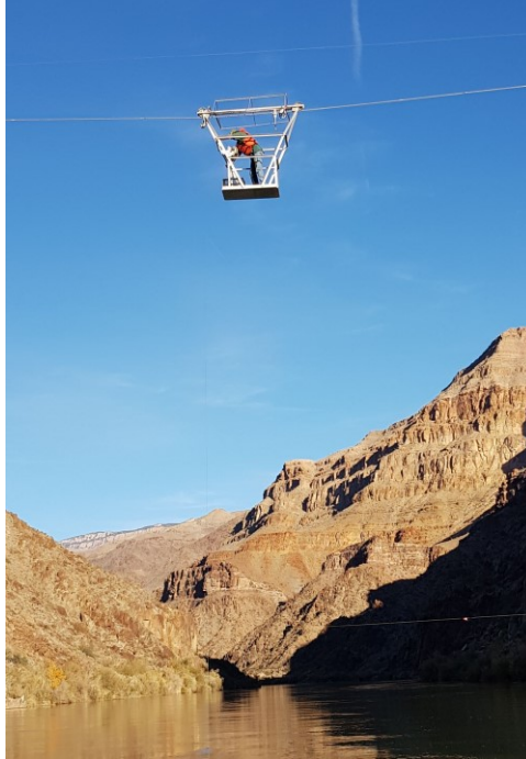
Figure 5 : Nacelle téléphérique de Diamond Creek sur le Colorado
