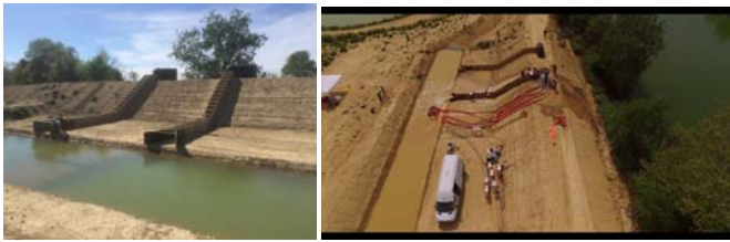
FIGURE 1 : LE DEMONSTRATEUR DIGUE ELITE, AVEC LES 2 CANAUX AVANT ESSAI
