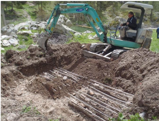
Photo 25 : Ré-enfouissement des paniers
