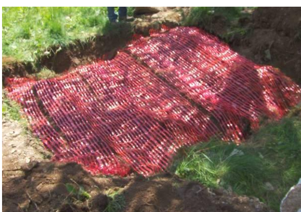
Photo 18 : Mise en place du grillage avertisseur
