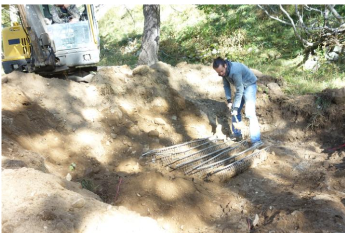
Photo 29 : disposition des 4 paniers restant (P5, P6, M5 et M6) avant ré-enfouissement.
