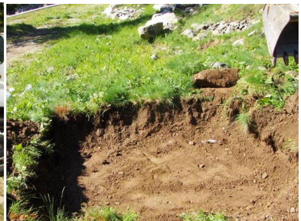
Photo 14 : Terrassement de la zone expérimentale
