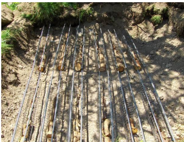
Photo 16 : Mise en place des paniers
