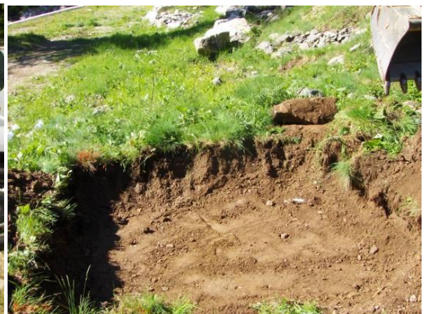
Photo 14 : Terrassement de la zone expérimentale
