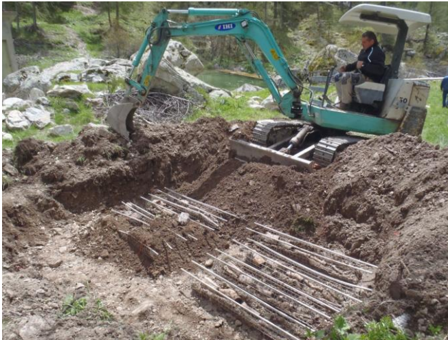
Photo 25 : Ré-enfouissement des paniers
