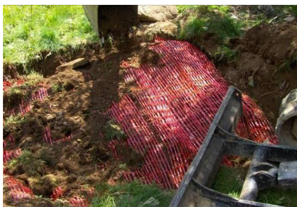
Photo 19 : Remblaiement de la zone
