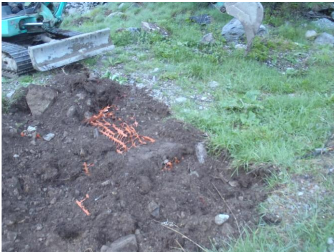
Photos 21 et 22 . Déterrage du dispositif à la pelle mécanique et récupération des paniers
