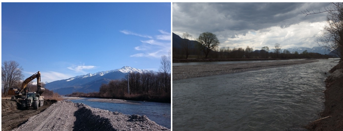
Figure 1 : Photos des travaux réalisés sur l'Isère en Combe de Savoie (photo SISARC) et d'un banc remodelé (photo Camenen)
