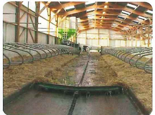
La prévention des boiteries repose sur les conditions d'hygiène et l'absence d'humidité.
