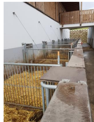
Photo 3 : système de relevage de barrières par câble désaxé
