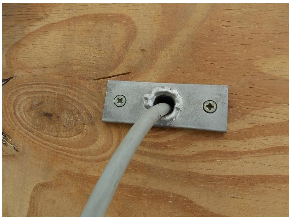
Figure 4. Passage du câble électrique souple au travers de l'axe central de rotation des lampes. (Photo : Frédéric Pascal, INRA PACA).
