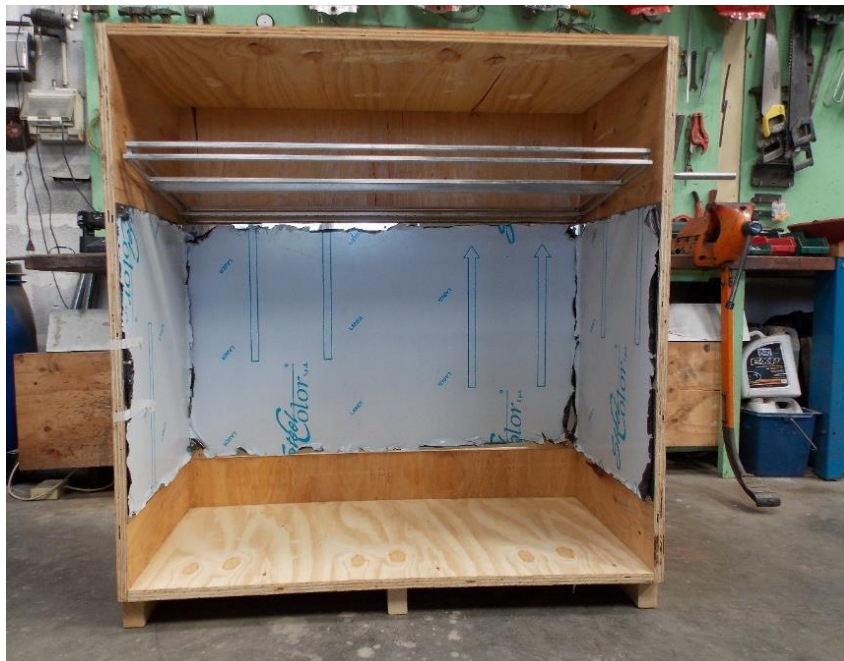
Figure 1. Enceinte en cours de construction. Les tôles en inox sont revêtues d'un film plastique qui protège de l'oxydation, et qui sera retiré au dernier moment. On aperçoit également le support des lampes et des ballasts. (Photo : Frédéric Pascal, INRA PACA).
