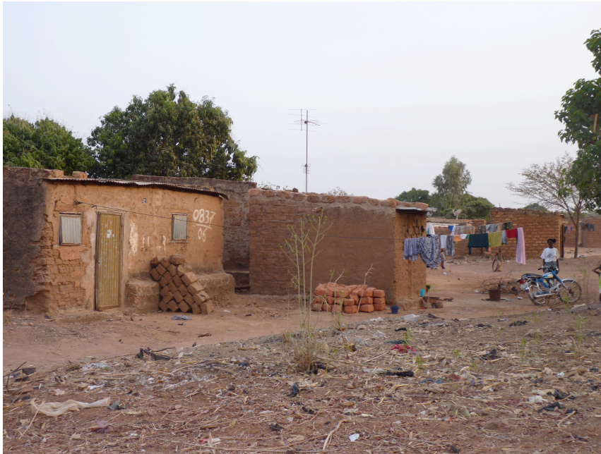
Figure 1 : Maisons en banco d'une zone non-lotie. L'antenne de télévision témoigne d'un accès à l'électricité via des raccordements illégaux au réseau électrique de la zone lotie voisine
