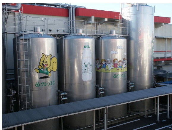
Chaîne de pasteurisation du lait Greencoop
