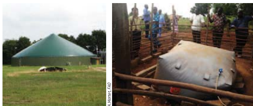
Ces unités de méthanisation (en Allemagne, à gauche, et au Ghana, à droite), de tailles très différentes, produisent une énergie renouvelable (biogaz) à partir des effluents d'élevage.
