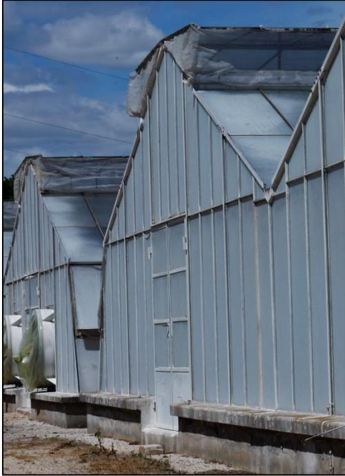
**Figure 3.** Installation de filets insect-proof sur les ouvrants d'aération des serres-verre.
