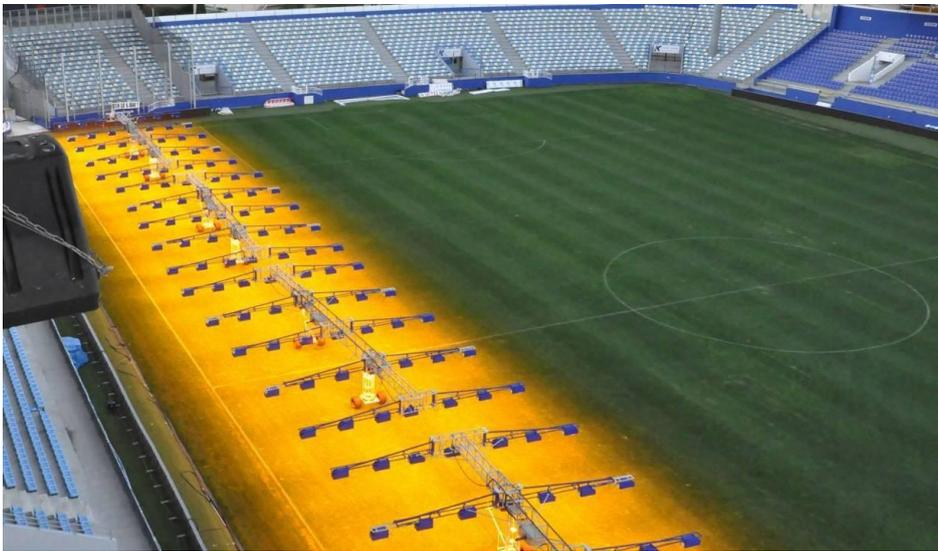
**Figure 10** : Illustration du dispositif d'éclairage artificiel utilisé pour compenser le manque de lumière dans les parties ombrées (cas du Stade de Furiani à Bastia).
