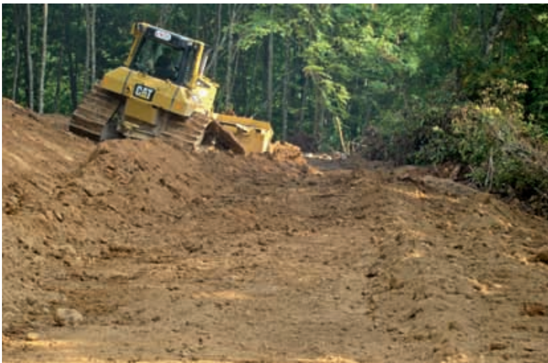
La création d'une route forestière pour camions grumiers peut être soumise à évaluation des incidences
