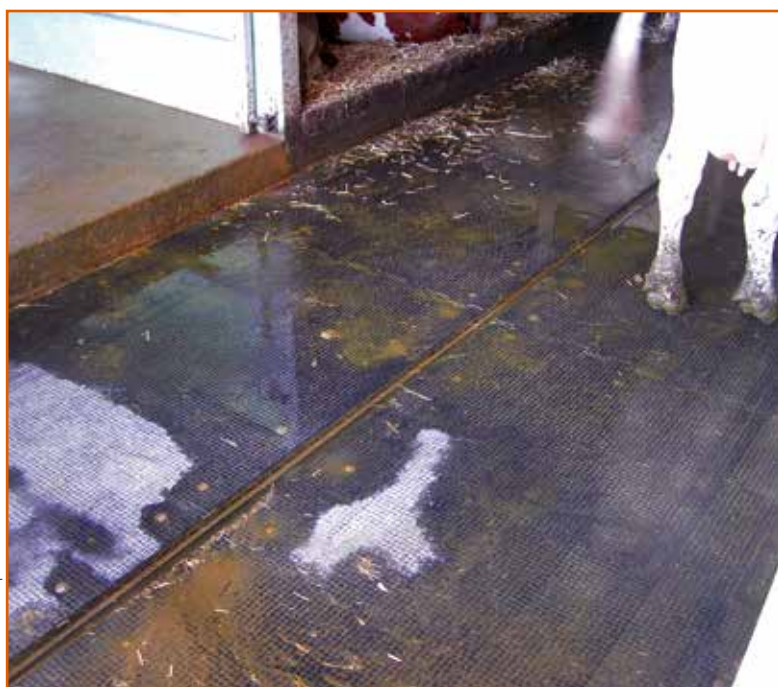
Photo 5. Un revêtement du sol moins dur peut être profitable aux vaches laitières, d'où le développement actuel des revêtements en caoutchouc dans les couloirs.
