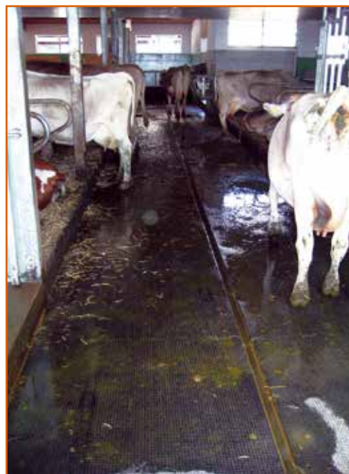
Photo 1. Couloir équipé d'un revêtement en caoutchouc.
