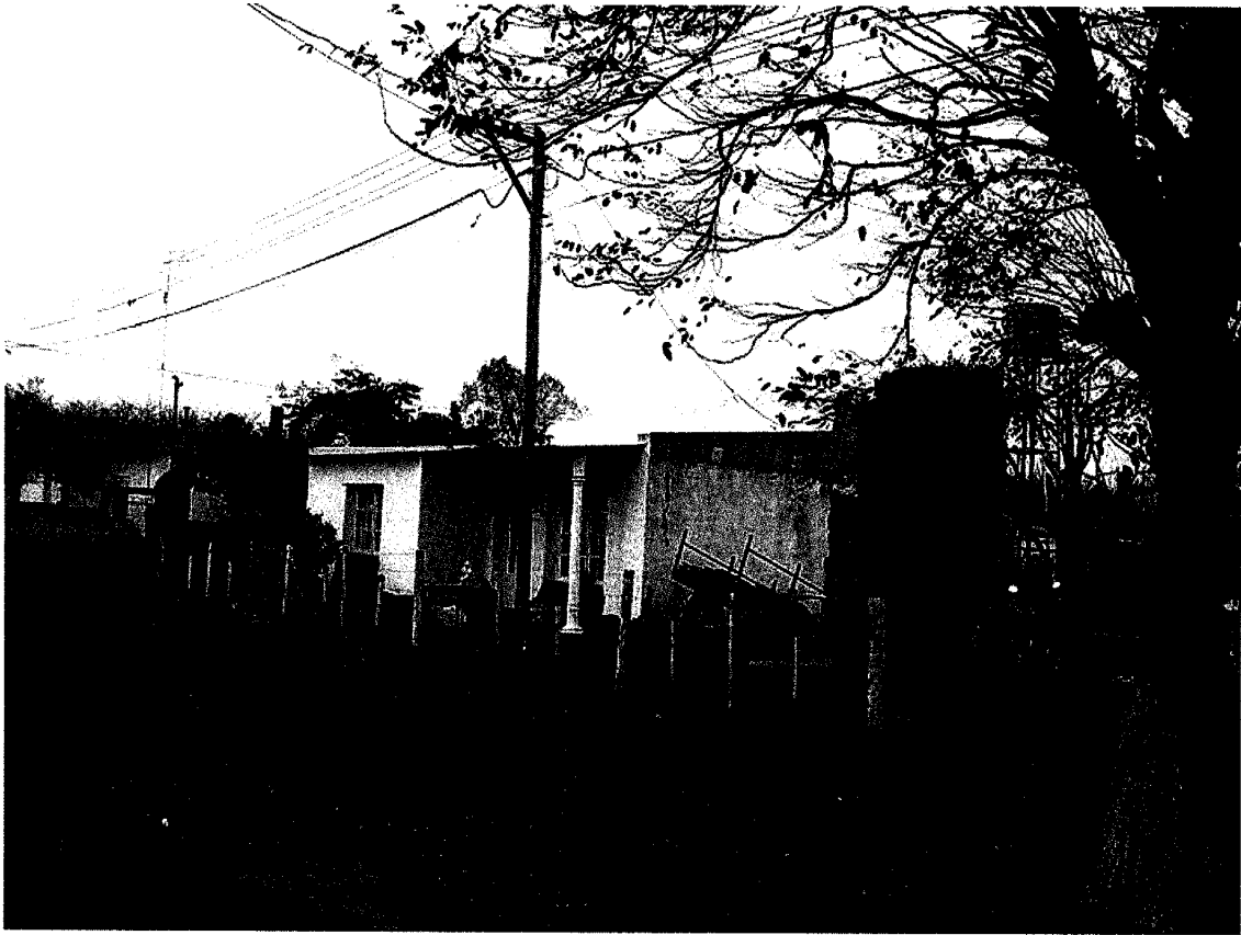
Maison d'ancien ouvrier agricole (cliché C. Albaladejo, 2011)
