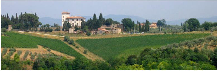
Photo 1 : la villa Le Corti à San Casciano in Val di Pesa (cliché C. Perrin, 2006) Photo 1: Villa Le Corti in San Casciano in Val di Pesa (photo C. Perrin, 2006)
