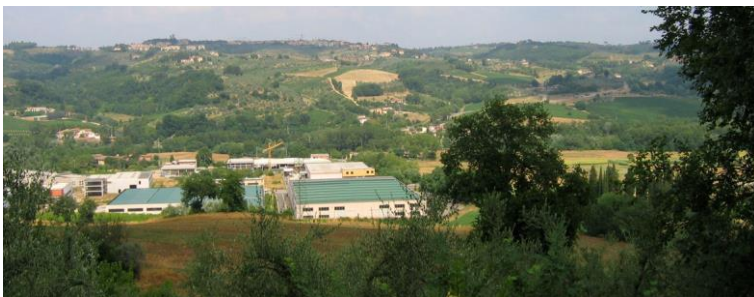
Photo 4 : développements industriels en fond de vallée, San Casciano in Val di Pesa (cliché C. Perrin, 2007)
