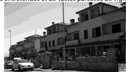
E. Maisons jointives (cliché C. Perrin, 2007).
