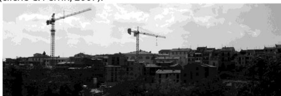
D. Immeubles en construction au chef-lieu (cliché C. Perrin, 2007).
