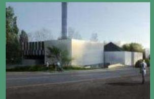
Dans le cadre du contrat de délégation de service public du chauffage urbain de la Ville Nouvelle de Rillieux-la-Pape, signé pour une durée de huit ans, Cofely s'est engagée à remplacer la centrale de production au fioul lourd existante par une centrale biomasse de 6 MW. Cet équipement, opérationnel en 2013, s'approvisionnera auprès de la filière bois locale pour 7 000 tonnes de bois-énergie par an, à partir de la plateforme d'approvisionnement de Saint-Maurice de Gourdans située à 30 km.
