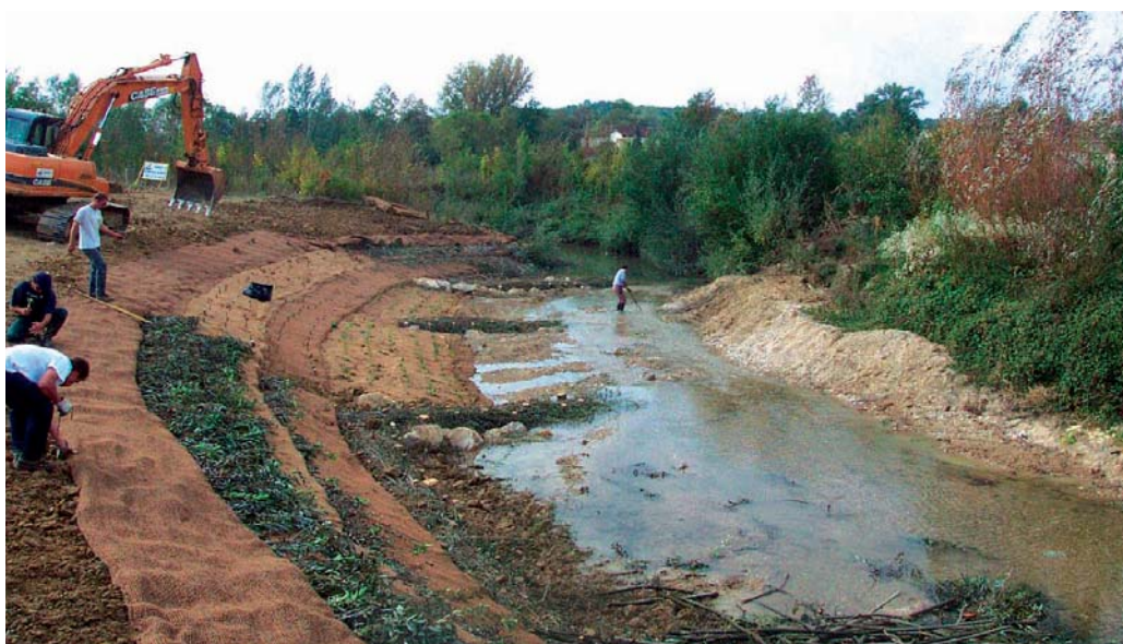
Renaturation d'un cours d'eau recalibré
