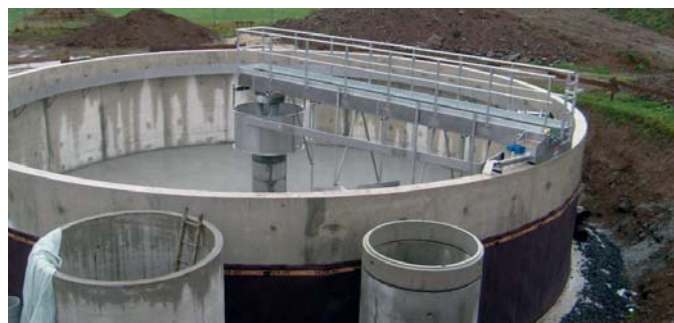
Chantier de la nouvelle station d'épuration
