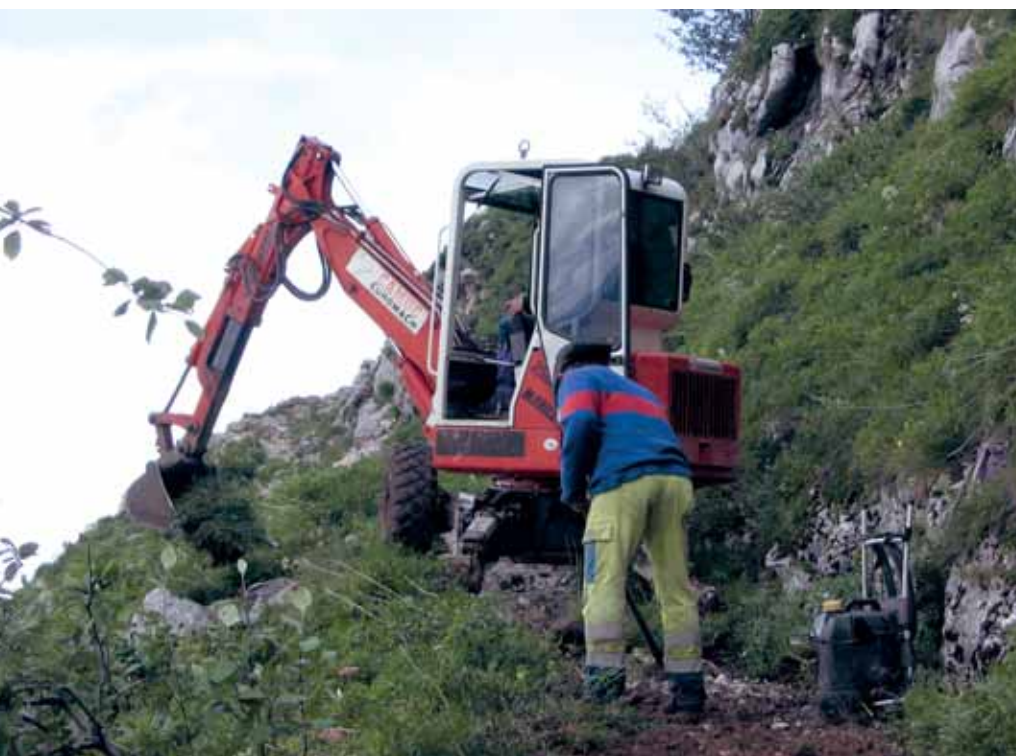
Restauration d'un sentier d'accès aux propriétés de l'ONCFS dans la Réserve des Bauges : élargissement et sécurisation préalable à la montée des génisses.
