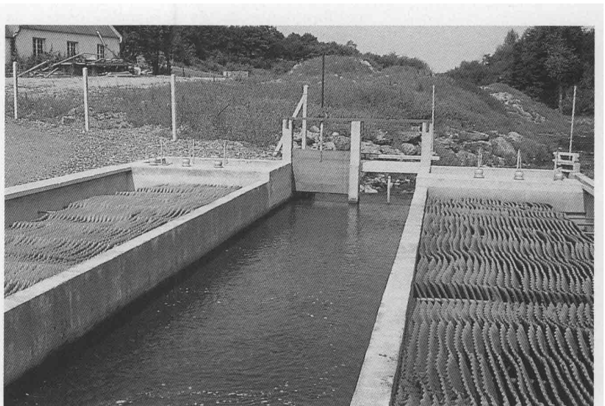
Décanteur lamellaire équipant la sortie d'eau d'une salmoniculture bretonne (vue à sec). Les ouvrages permettant d'atteindre une dépollution, même limitée en taux (20 à 40 % d'abattement), sont souvent volumineux, complexes et coûteux.
