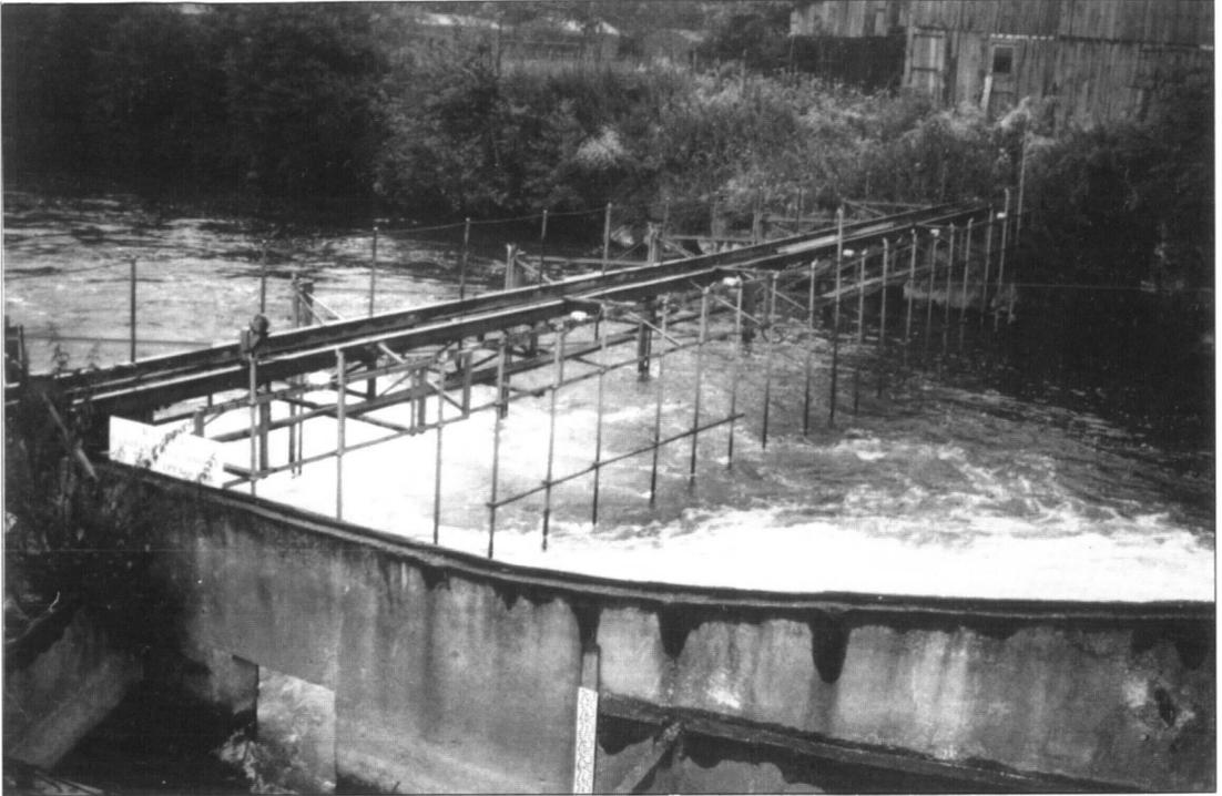
**Photo 1 : Vue de l'écran électrique et de l'entrée de la passe à poissons de Chopolo.**
