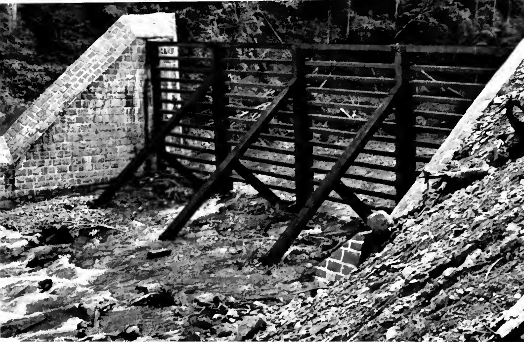
Photo n° 4 : Le barrage perméable de protection du Ried am Ziller, au bas de la Gorge du Riedbach : grille métallique démontable formant piège à sédiments grossiers, susceptible de purge artificielle (aérodéposition contrôlée)
