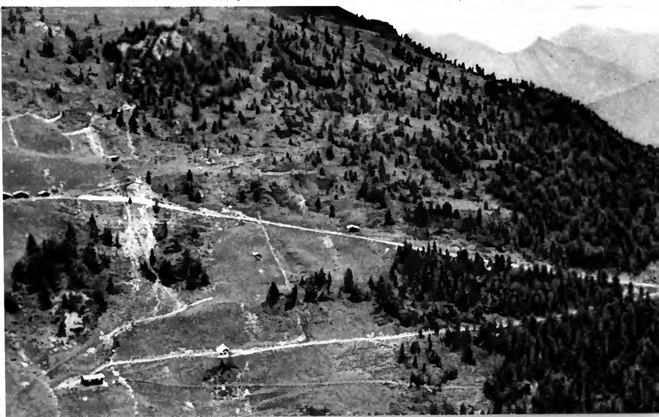
Photo n° 3 : Rive gauche du bassin du Telbech (Zillertal) vers 1.950 m d'altitude. Travaux d'équipement sylvopastoral : route desservant la forêt et les alpages améliorés et consolidés par des travaux de drainage visibles au-dessus des chalets.
