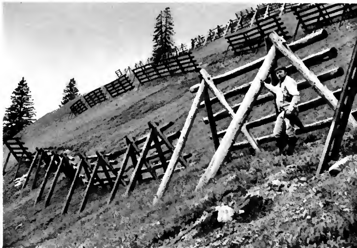
Photo n° 5 : Protection provisoire par claires rustiques en bois Photo PONCET
