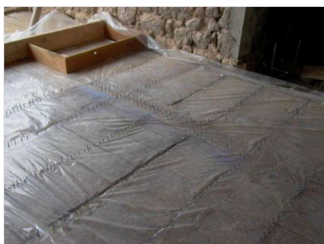
FIG. 1 – Plancher mixte bois-béton.
