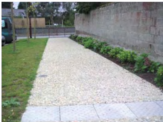
Photo n°12 : Une allée piétonne complètement imperméabilisée. Les eaux de l'allée vont vers les surfaces végétalisées
