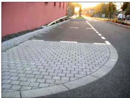
Photo n°11 : Des pavés dessinés au sol avec de la résine coulée pour matérialiser les zones de stationnement.
