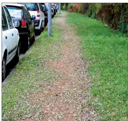
Photo n°1 : Photo d'un trottoir en stabilisé tordu en milieu urbain de Vichy
