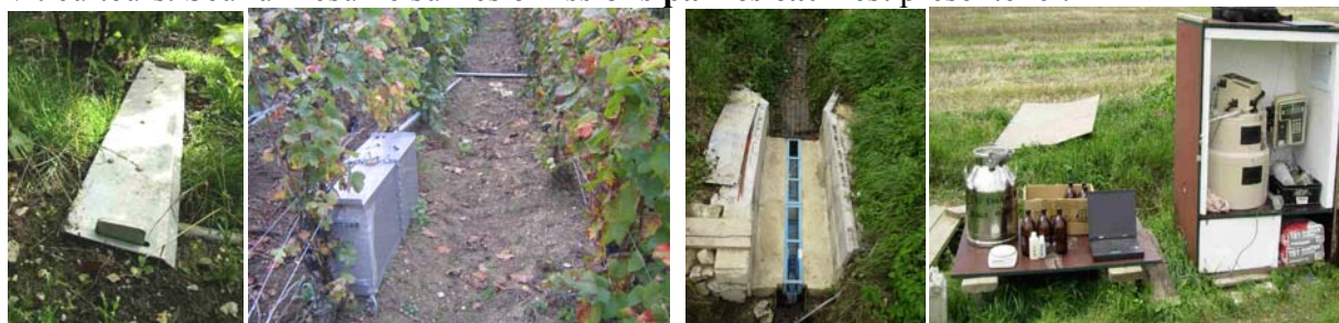
Figure 1 : Systèmes de collecte des eaux en placette (caniveau et cuve) et en fossé aval de versant (canal, débitmètre, préleveur d'échantillons)
