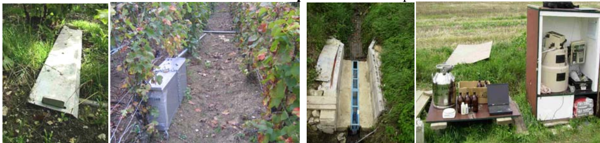
Figure 1 : Systèmes de collecte des eaux en placette (caniveau et cuve) et en fossé aval de versant (canal, débitmètre, préleveur d'échantillons)
