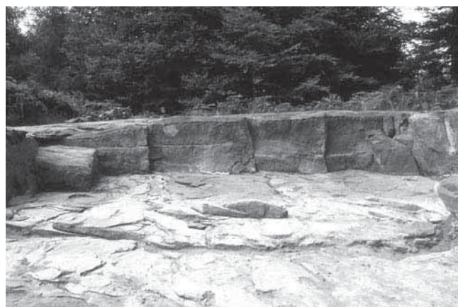
Figure 8 : Carrière de Saint-Quirin, La Croix Guillaume (cliché D. Heckenbenner).
