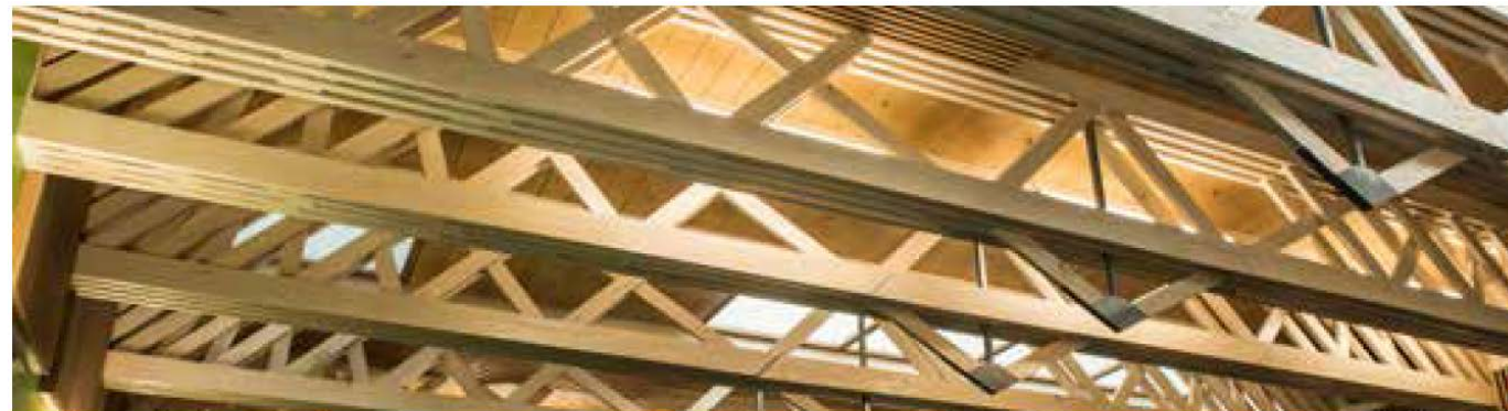
Charpente en peuplier massif de la Salle Polyvalente de Lezennes (59). ARCHITECTE : LAURENT BAILLET, BET : INGÉBOIS STRUCTURES, ENTREPRISE BOIS : AS BOIS
