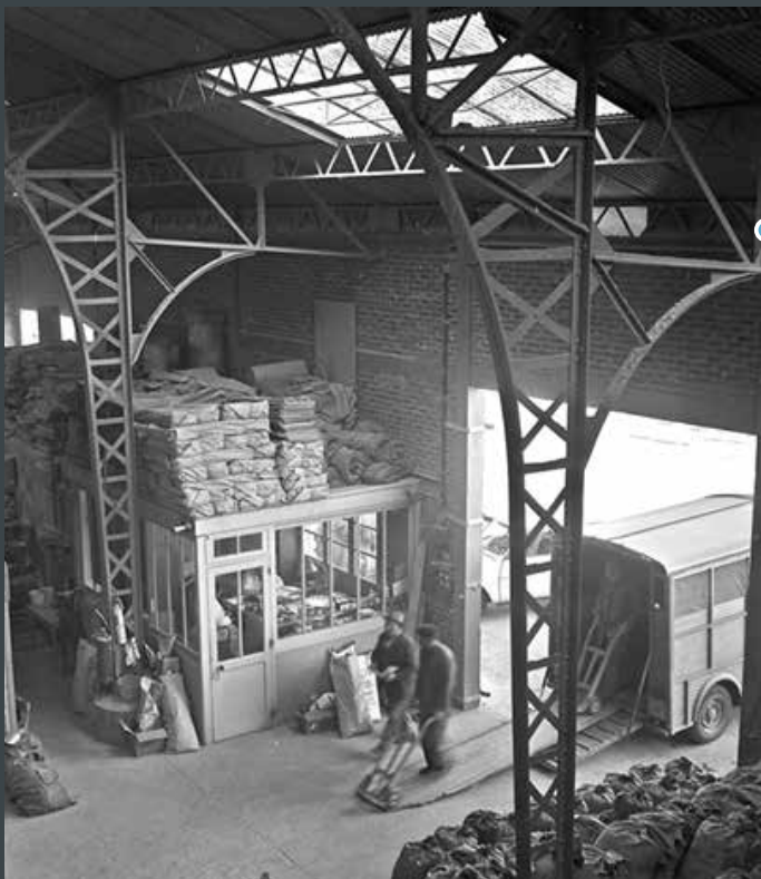
Dans les années 1960, Jean-Joseph Weber immortalise une vue intérieure du moulin de La Minière, sur l'exploitation de la ferme de Guyancourt, achetée en 1952 par l'Inra. Sur ce domaine de 260 hectares sont installés des laboratoires et des services et notamment le « moulin », usine de fabrication d'aliments pour les expérimentations menées par les zootechniciens. Bernard Giboulot, « technicien 2B » dirige alors cet atelier où arrivent par énormes camions les matières premières achetées à la Bourse du Commerce et nécessaires à la préparation des aliments. Cinq personnes sur ce cliché : les trois hommes sont vraisemblablement Bernard Giboulot et deux ouvriers-magasiniers poussant des diables. Le témoignage Archorales de Sylvain Drevet, recueilli en décembre 2000 par Denis Poupardin et paru dans le tome 8 de la revue Archorales , est précieux pour reconstituer ce qui se montre par ce cliché. Dans le bureau vitré, deux hommes peuvent être Sylvain Drevet, ingénieur 1B chargé de vérifier la qualité des aliments et de tester les protocoles de fabrication, avec un chercheur du laboratoire de Nutrition sis à la Minière ou avec un chercheur de passage : les chercheurs passaient commande afin d'obtenir les mélanges contenant des ingrédients spécifiques - tels que protéines, hormones, vitamines - pour leurs expériences et leurs recherches en cours. Il leur arrivait de se rendre au moulin de La Minière pour vérifier avec les techniciens la teneur en tel ou tel élément des aliments élaborés. © Inra - Jean-Joseph Weber
