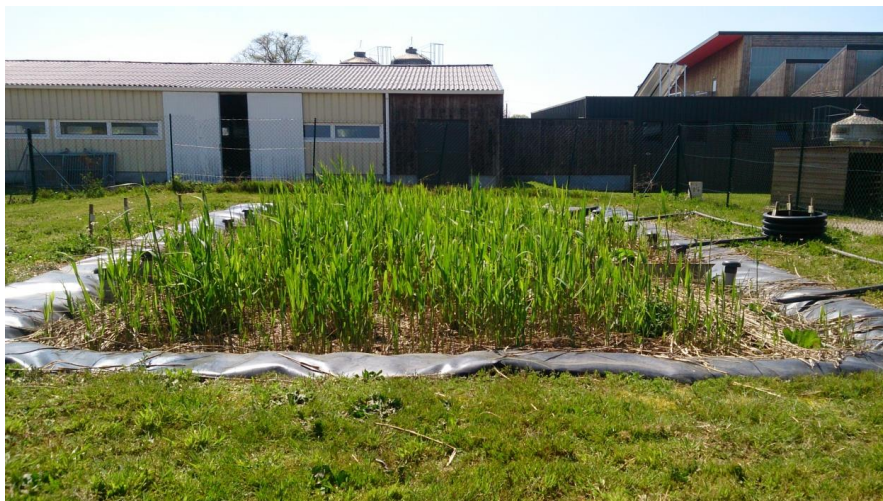
Figure 8 : Photo du filtre planté de roseaux de Patuchev à Lusignan
