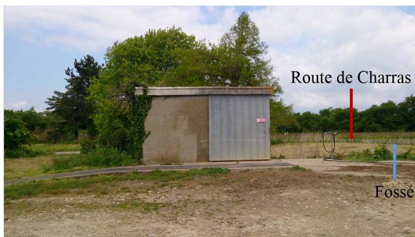
Figure 6 : Station de lavage actuelle
