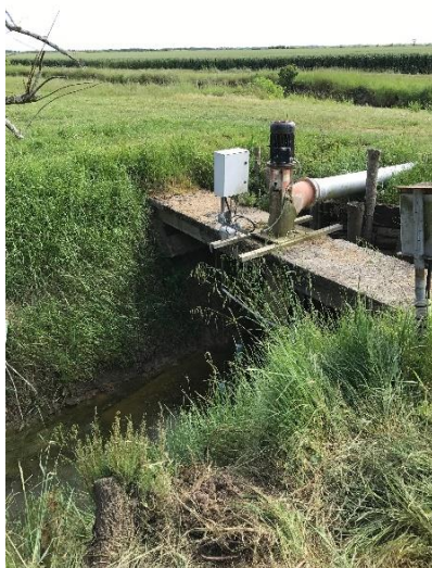
Figure 10 : Photo du fossé en amont de la pompe de rejet
