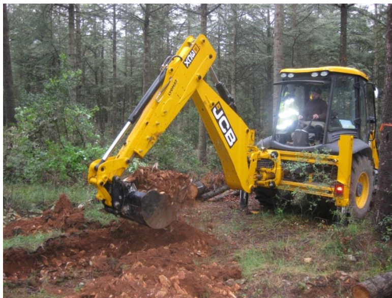
Figure 3. Creusement des fosses dans le dispositif cèdre de Valliguières
