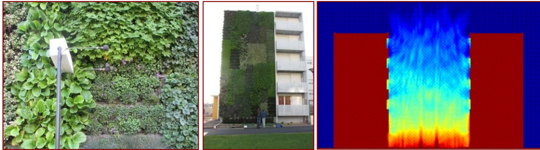
Figure 30. Illustrations des mesures et modélisation de l'impédance acoustique des surfaces végétalisées (façades et toitures) réalisées dans le cadre du projet VegDUD (2010-2013)
