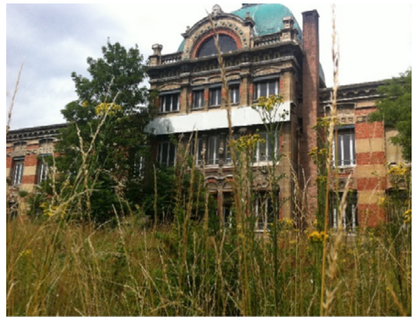
FIGURE 1. LE CHÂTEAU AVANT SA RÉNOVATION
