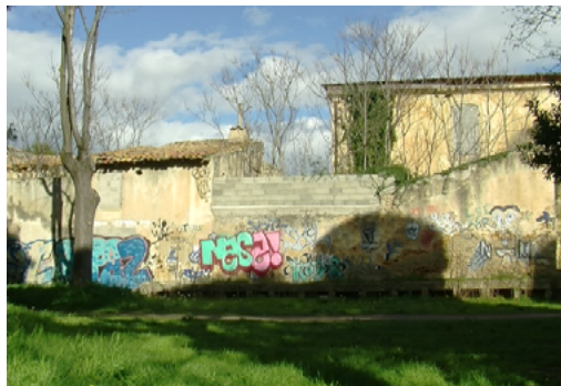
FIGURE 4. BÂTISSSE DE L'AGRIPARC, RECOUVERTE DE TAGS
