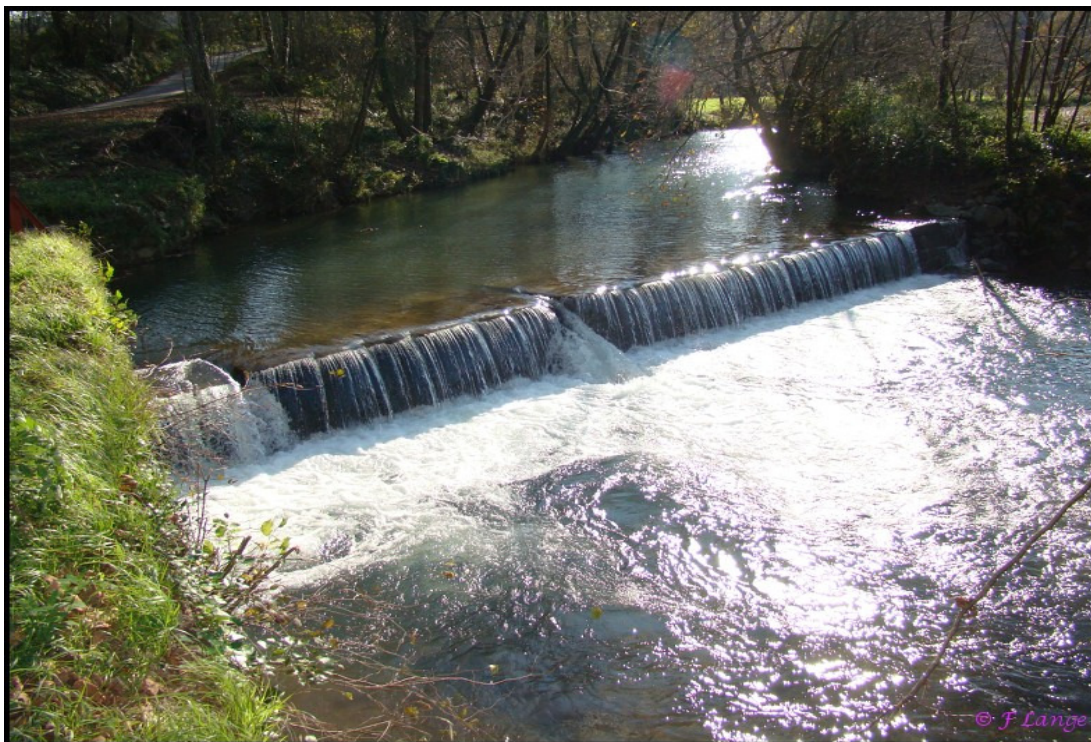
Barrage Ibarla (Lurgorrieta)
