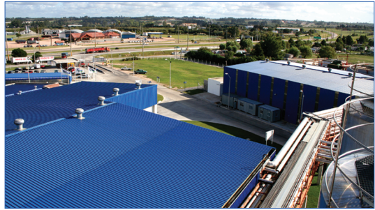
Figure 8. Le parc industriel de Conaprole est constitué de huit laiteries localisées à Florida, Villa Rodríguez, Canelones, San Carlos/Maldonado, Rincón del Pino/San José, Rivera, Mercede/Soriano y Montevideo. La dernière inaugurée en 2004 est entièrement automatisée (Source : http://www.conaprole.com.uy ).
