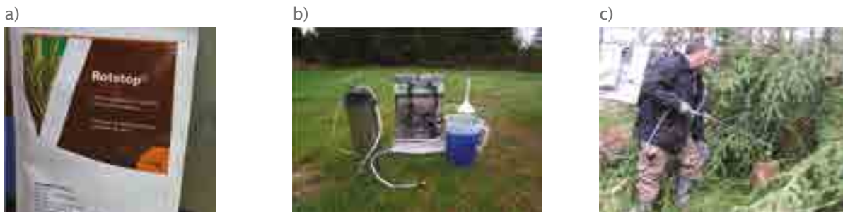
Figure 1 : Préparation et épandage du ROTSTOP™. a) Traitement ROTSTOP™ et colorant TURF. b) Préparation de la bouillie dosée à : 1 g de ROTSTOP™/litres d'eau/m². c) Application du traitement sur souches fraîches à l'aide d'un pulvérisateur.
