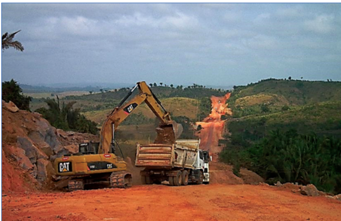
Figure 5. De nouveaux grands travaux pour dynamiser la région et rompre son enclavement.
