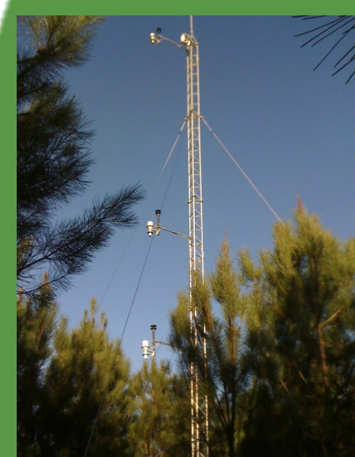
Photographie du mât de mesure des profils verticaux de l'humidité de l'air, de la température, du vent.
