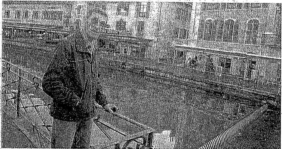
Patrick Michaud devant la vanne à clapet du Pont Perrière, la plus importante de la ville. La jauge du pont de la Halle est le point de repère officiel (photo ci-dessous).
