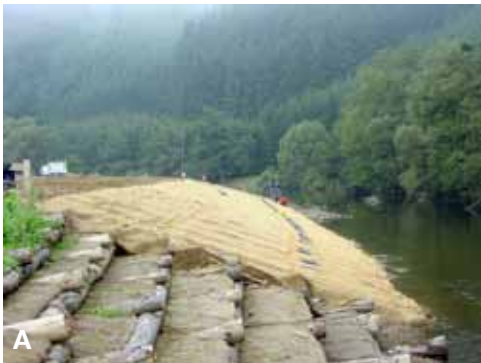
Figure 1.8. Installation d'un caisson végétalisé sur l'Our (A) et développement végétatif obtenu après 3 ans (B).
