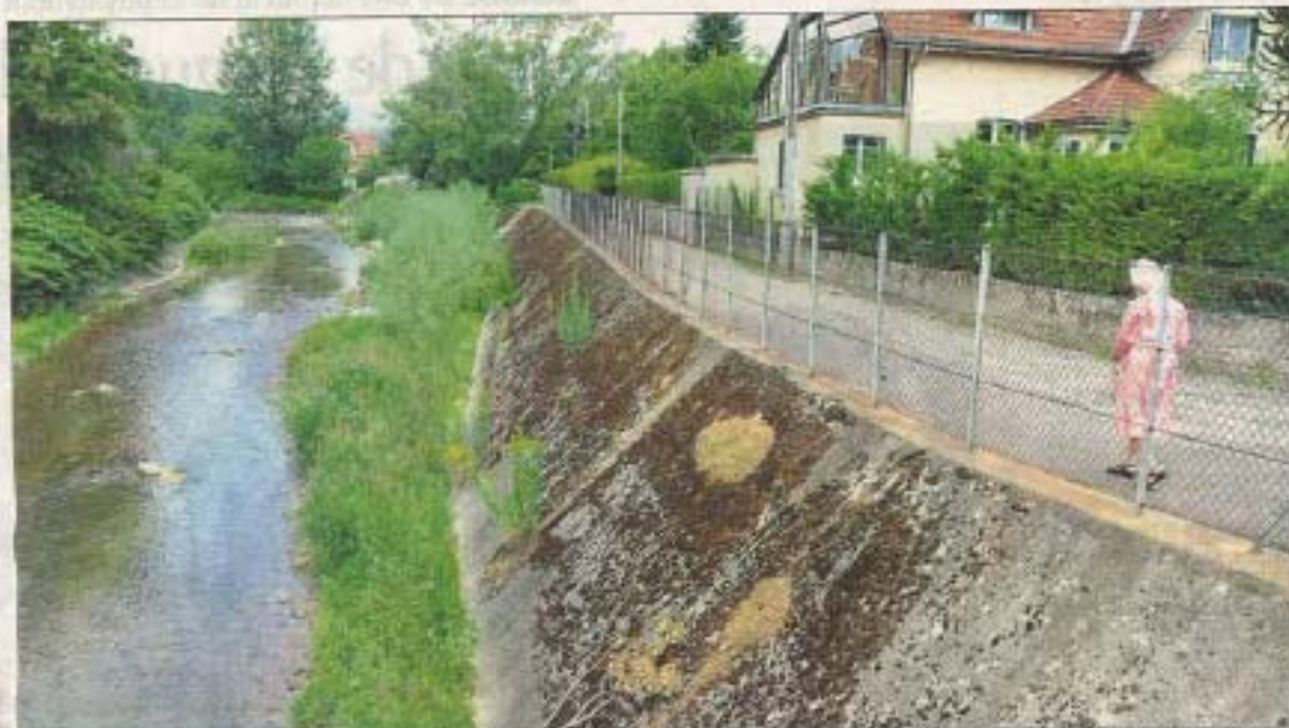
Le plan de prévention des risques d'inondation a déclaré inconstructible toute une zone autour des digues du Sierroz en raison d'un toujours possible débordement du cours d'eau. Les travaux visent à endiguer une éventuelle crue. Plus 66
