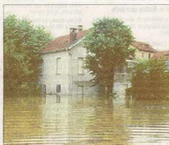
21 JUILLET 1992. Il tombe 160 mm d'eau en une heure. Les dégâts, sur la voirie, sont estimés à plusieurs centaines de milliers d'euros.
