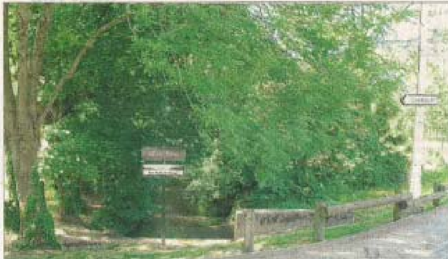
Le bassin d'orages de 10000m 3 se situera à l'intersection entre le chemin des Biâtres et le boulevard Garibaldi. Sur cette zone lors des prochains travaux liés au Tillet, le cours d'eau sera légèrement dévié sur la gauche.
