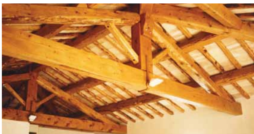
39 - Charpente en cèdre récolté au mont Ventoux.
