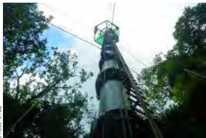
Un des trois pylônes de 45 mètres de hauteur du système Copas. Une nacelle se déplace le long des câbles qui les relient, permettant aux scientifiques de prendre de la hauteur pour étudier le sommet de la forêt.
