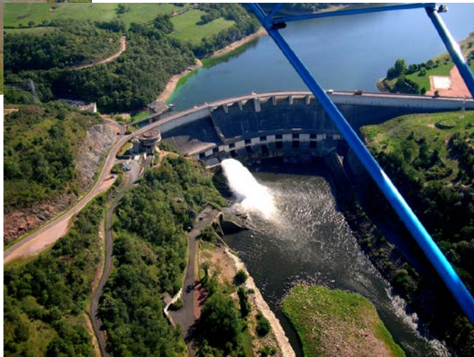
Barrage de Villerest au sud de Roanne
