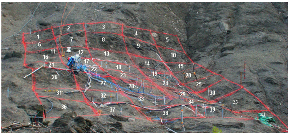
Figure 3 : Photographie de la surface d'étude sur le glissement de terrain du bassin versant du laval, quadrillée de 1 à 40.
