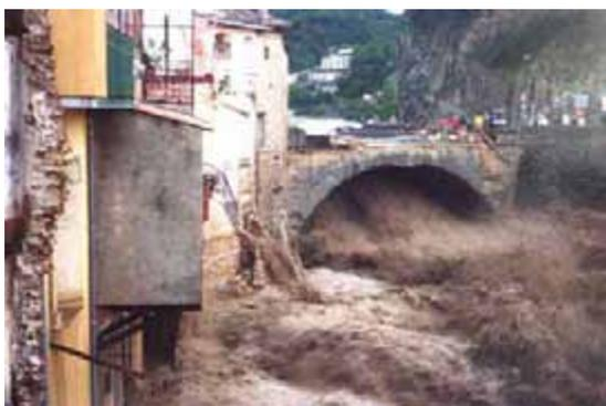
**Figure 29.** Crue à Vaison-la-Romaine le 22/09/1992. Le pont (1er s. ap. J.C.) sur la rivière Ouvèze a résisté au flot, alors que des ponts et constructions plus récents ont été détruits. Photo : M. J. Tricart.
