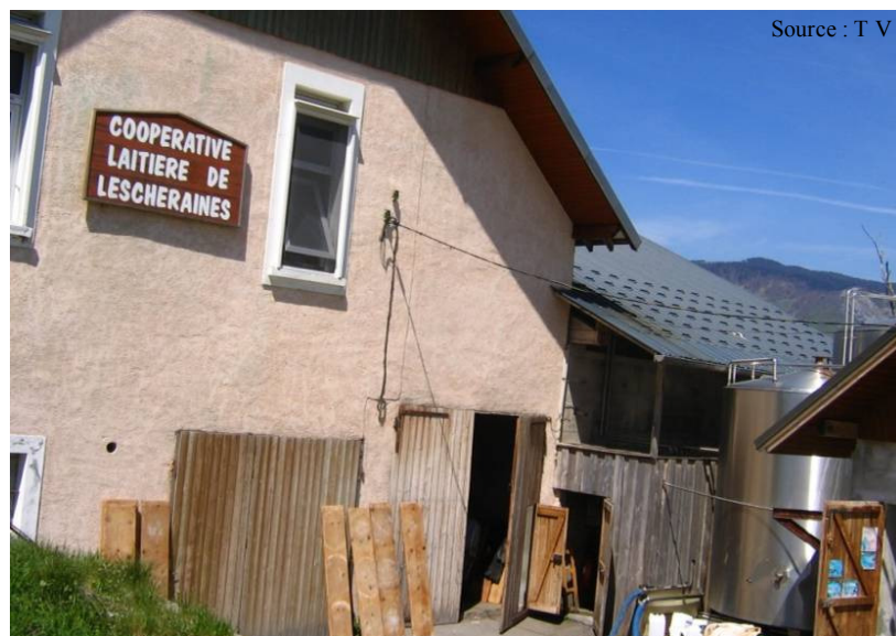
Photographie 1 les bâtiments d'une unité de transformation baujue
